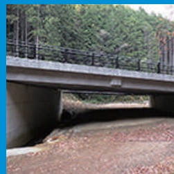
橋りょうPC上部
