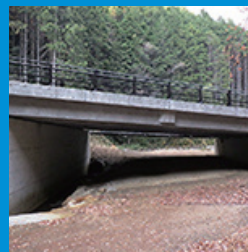
橋りょうPC上部
